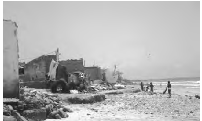
Photo 1: Maisons détruites à Bargny
