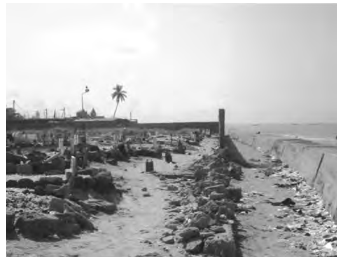
Photo 2: Le mur du cimetière de Diokhoul endommagé par la houle
